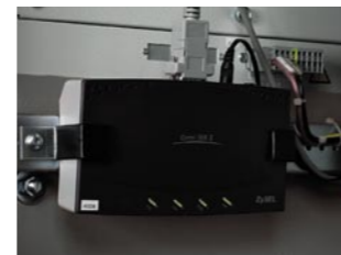
Möglichkeit zur Datensammlung und Modemverbindung für die Fernwartung der Maschine.
